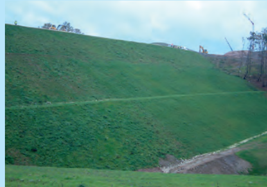
Talus enherbé. © Cerema
