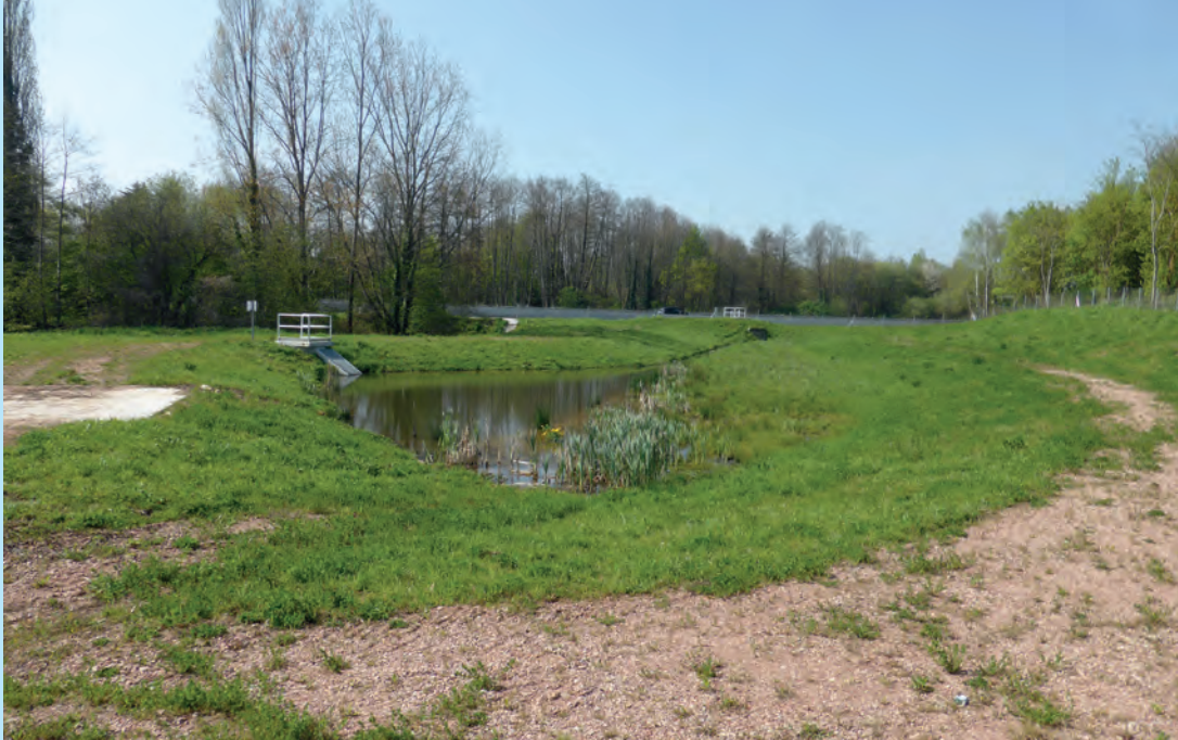
Bassin d'assainissement en terre. © Cerema
