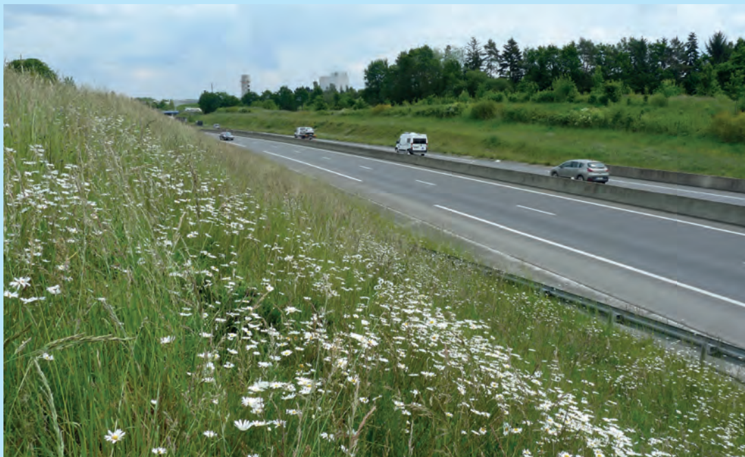
Dépendances routières fleuries. © Cerema
