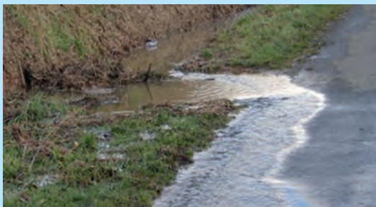
Fossé comblé par les résidus de broyage. © Laëtitia Citeau
