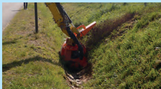
Curage à la rotocureuse. © CD Côtes d'Armor
