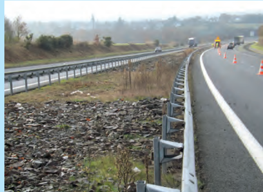
Matériaux caillouteux sur terre-plein central. © Cerema
