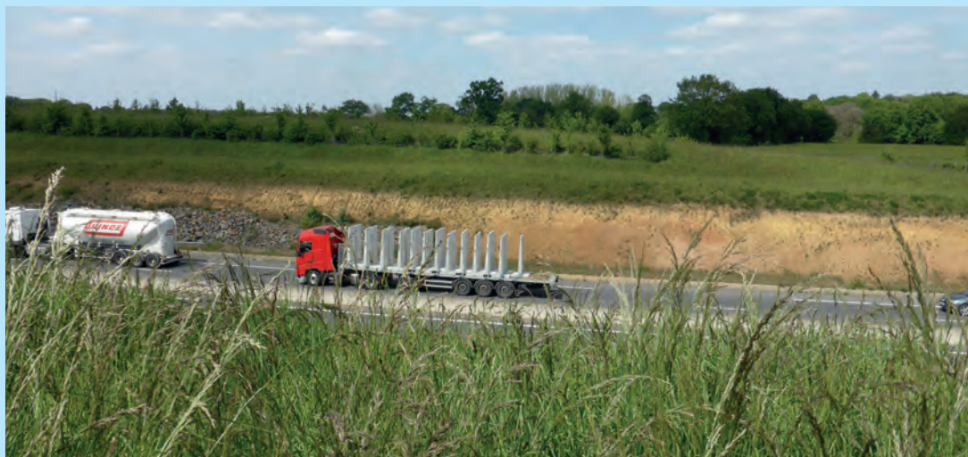
Talus routier non végétalisé. © Cerema
