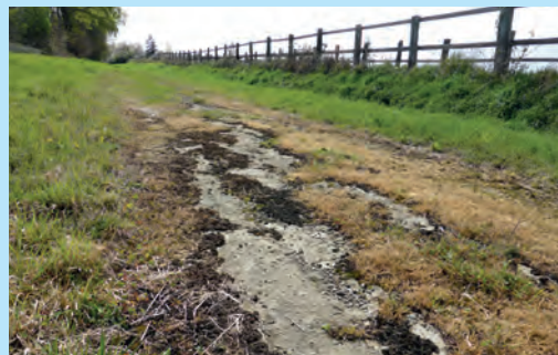
Chemin empierré sur dépendances. © Cerema
