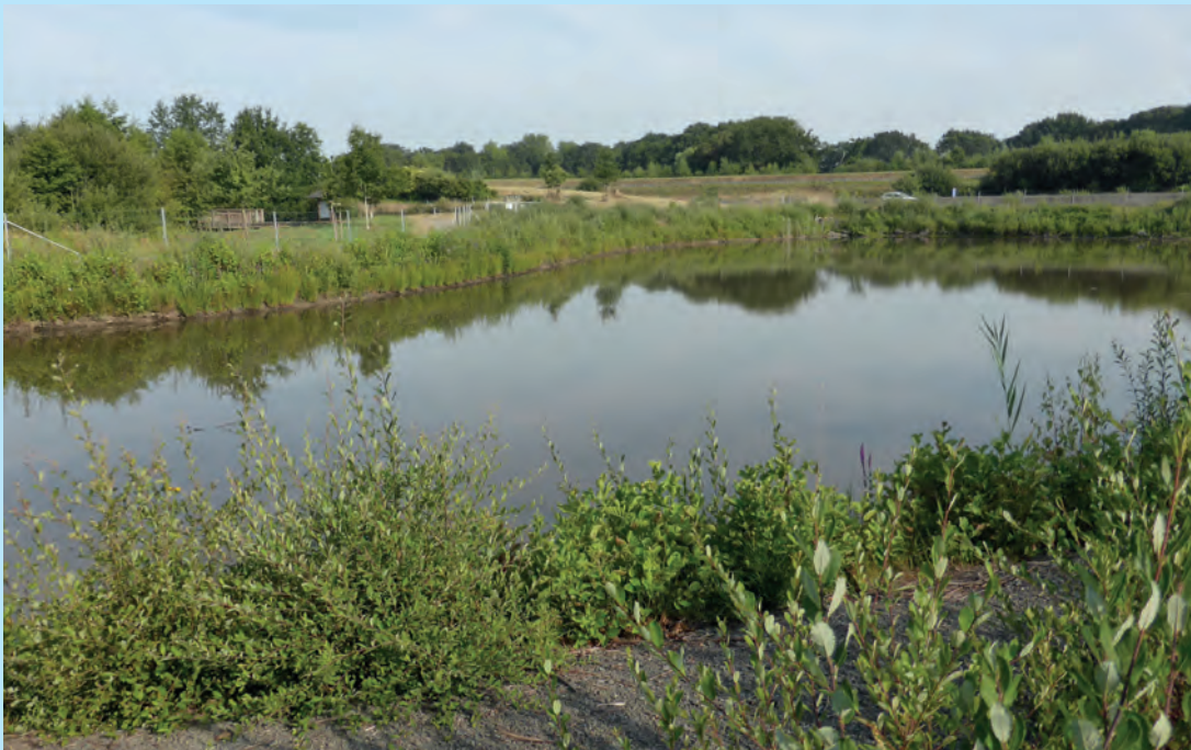
Bassin d'assainissement sur géotextile. © Cerema
