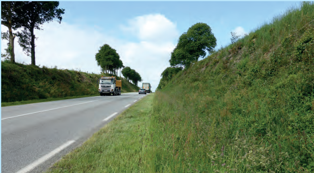
Absence de résidus herbeux après broyage-aspiration. © Cerema
