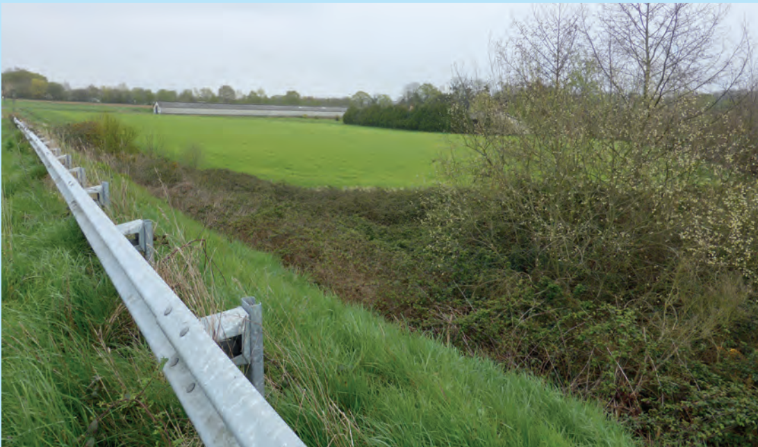
Non gestion de la strate arbustive en zone C. © Cerema
