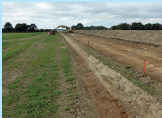
Végétalisation nécessaire lors des travaux. © Cerema
