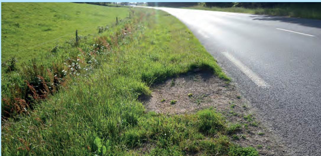
Saignée d'accotement pour gestion des eaux. © Cerema
