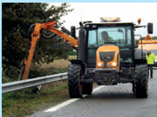
Fauchage-débroussaillage. © Guide matériel, Sétra 2013
