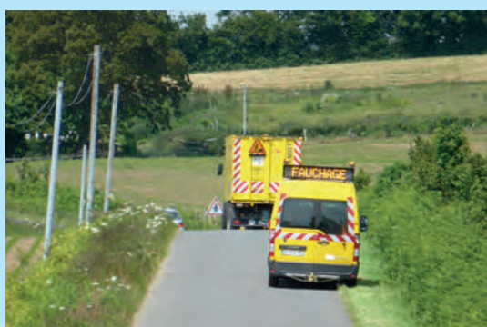
Balisage de sécurité. © Cerema
