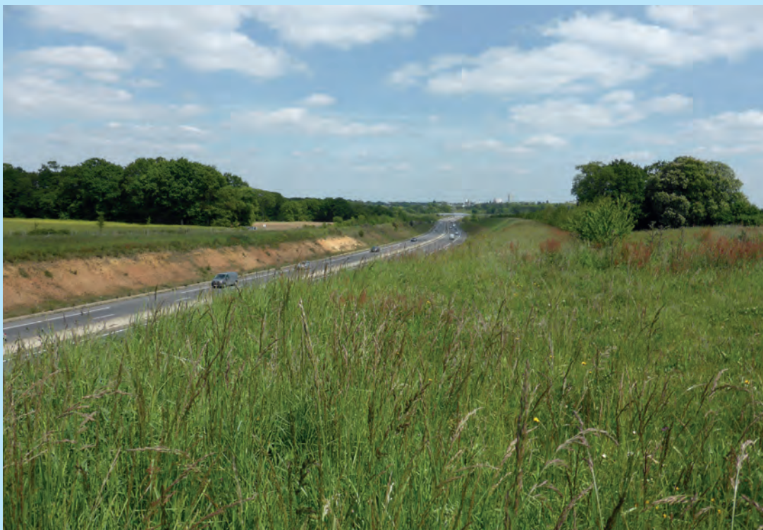
Dépendances vertes de 2x2 voies (50 m de large de chaque côté). © Cerema
