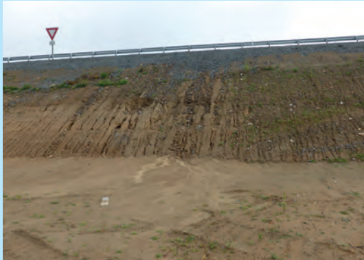
Érosion de talus avant végétalisation. © Cerema
