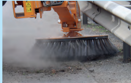
Nettoyage par broyage du terre-plein central. © Cerema
