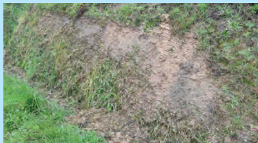
Broyage excessif des fossés. © Laëtitia Citeau
